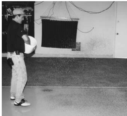
Cubra el epóxico o uretano completamente
