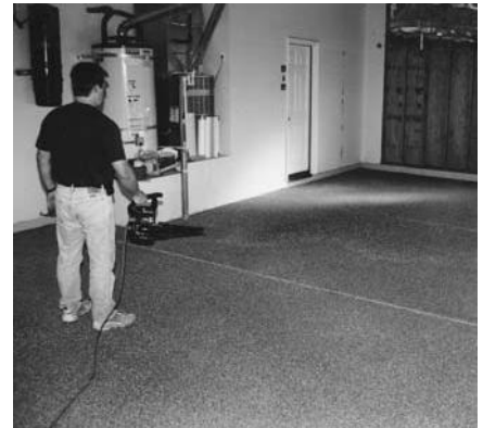
Sople las hojuelas sueltas en áreas delgadas sólo si es necesario.
