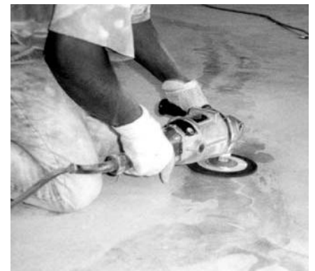
Lije el epóxico sobre la fractura
