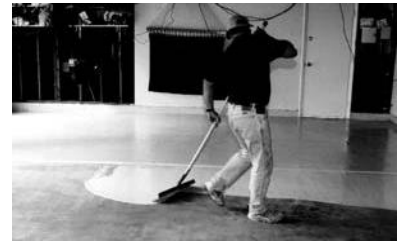
Aplique una capa con jalador si se necesita
