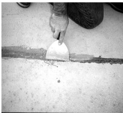
Rellene fracturas con Sealcoat 500 y lije
