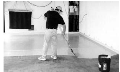
Aplique Epoxy 200 con jalador metálico
