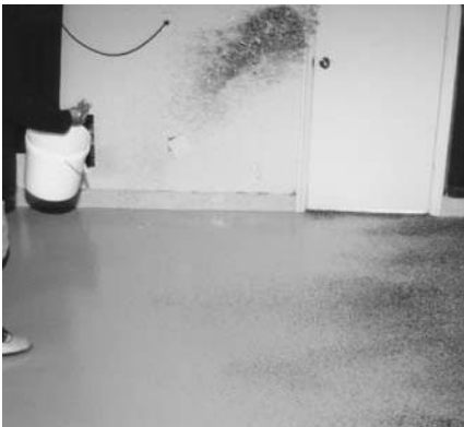
Método1: Lance las hojuelas en el aire a mano
