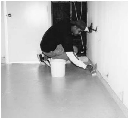
Aplique WB Epoxy o Uretano SB o HP en orillas
