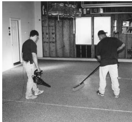
Raspe la superficie y sople para retirar hojuelas sueltas
