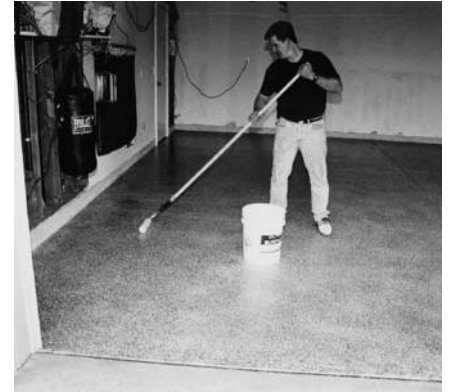
Aplique la primera capa de SB Urethane sobre las hojuelas
