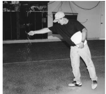
Espolvoree hojuelas en áreas delgadas y en orillas
