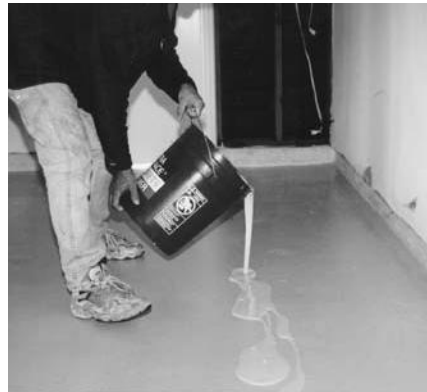
Vierta el epóxico o uretano junto a la orilla inicial
