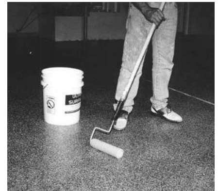
Aplique la segunda capa de SB Urethane
