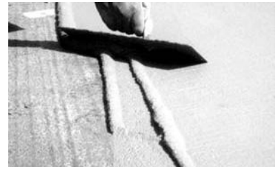
Parche los agujeros o áreas que necesiten reparación
