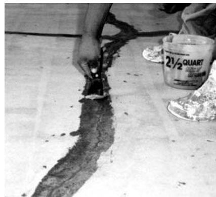
Raspe el exceso de epóxico, deje un poco
