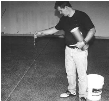
Espolvoree las hojuelas si necesita una apariencia Uniforme.
